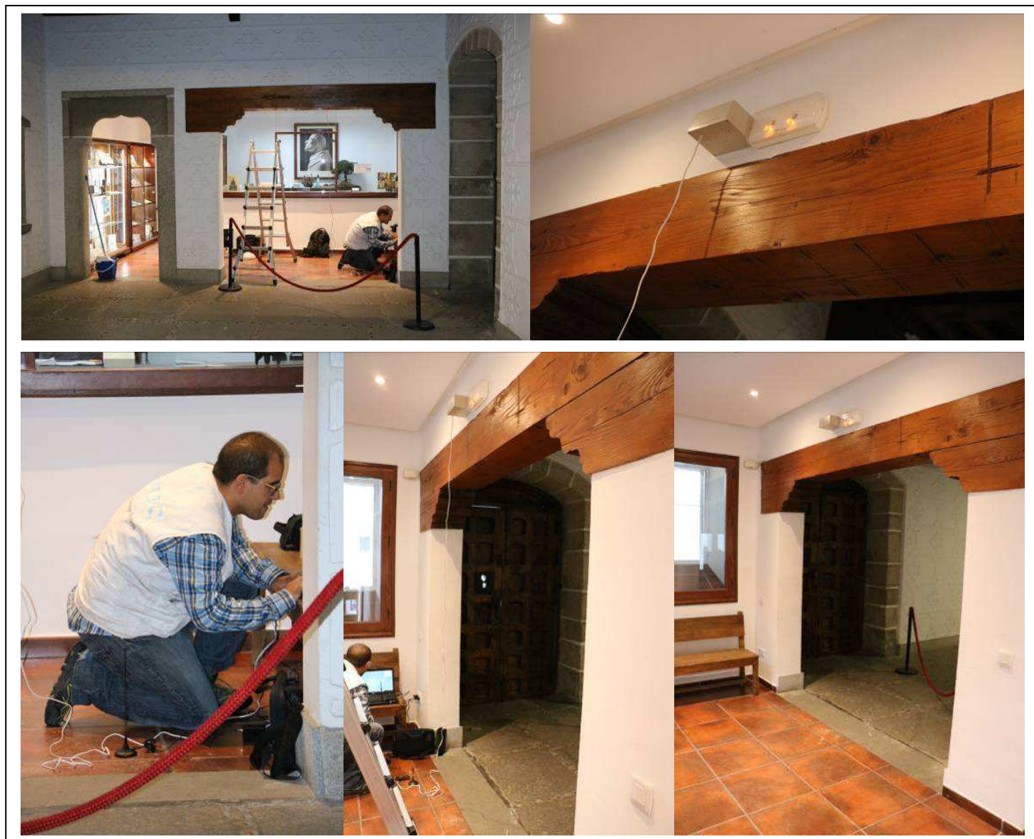
Figura 8. Instalación de una cámara de conteo y un nodo repetidor en el Monasterio de Santo Tomás
