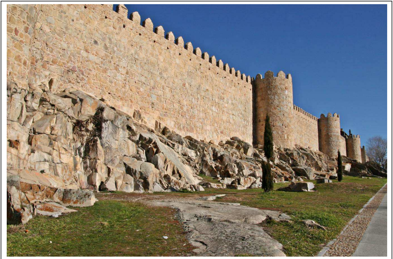
Figura 5. Vista parcial de la muralla de Ávila
