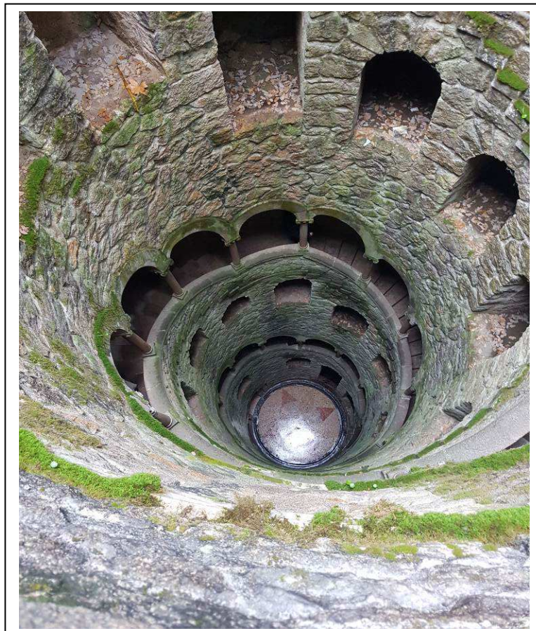
Figura 14. El Poço iniciático (Quinta da Regaleira) precisa sensores de humedad y fisurómetros.
