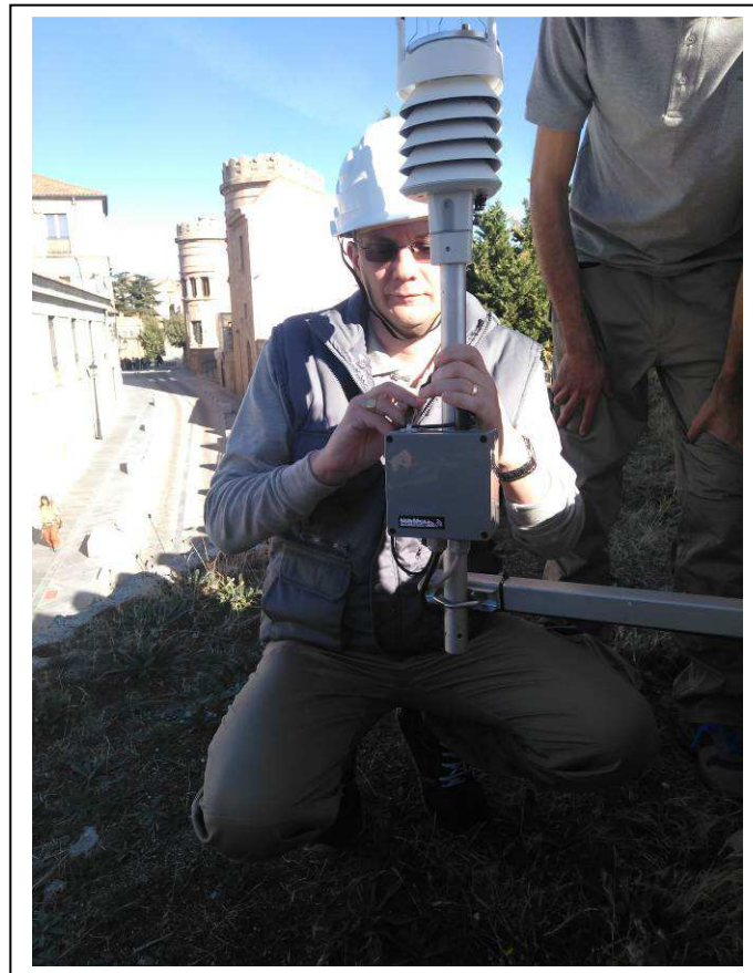
Figura 6. Instalación y configuración de una estación meteorológica en un punto de la muralla de Ávila
