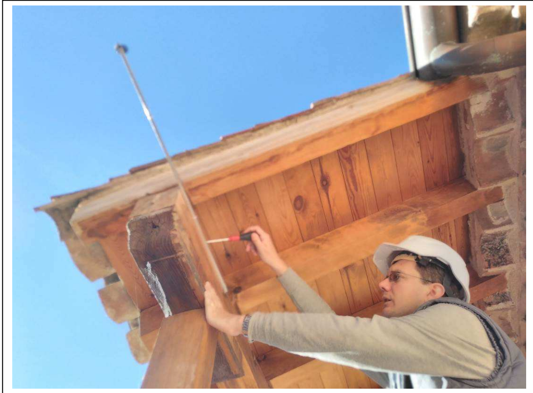
Figura 7. Instalación y configuración de un sensor de radiación solar y de un sensor de xilófagos y humedad de la madera en el palacio de Caprotti o Superunda. Este palacio del siglo XVI, de estilo renacentista, fue declarado en 1992 Bien de Interés Cultural con categoría de monumento
